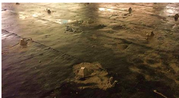
Figura 4 – Execução de manta acústica.
