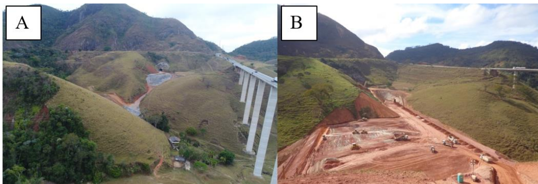
Figura 2 - Grota seca a ser cruzada pelo traçado (A) e execução do corpo do aterro (B).
