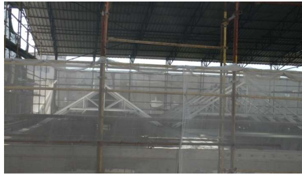
Figura 8 - Estrutura metálica da cobertura do Palácio.
