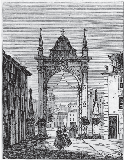
Arco da camara municipal
