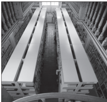
Depósito norte depois da intervenção.
