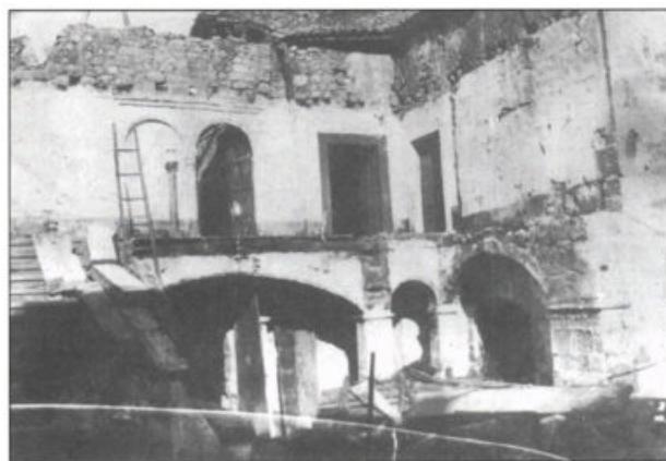
• Pátio e a escada, ano de 1906. • Início da demolição.
