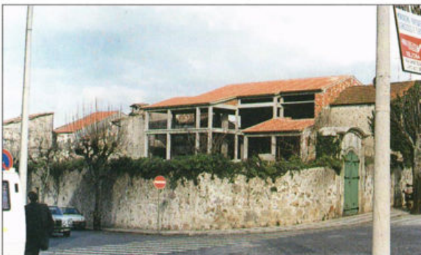
2. Traseiras e logradouro do edifício do Antigo Albergue
