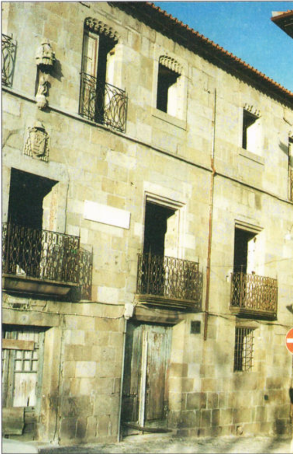
1. Fachada do edifício do antigo Albergue Distrital
